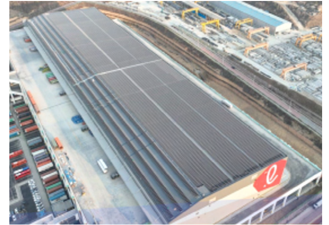
진천 택배 Mega-Hub 터미널
